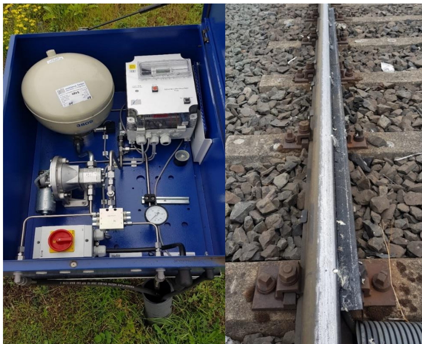
Abbildung 88: Spurkranzschmiereinrichtungen (Quelle: Duisburger Hafen AG)
